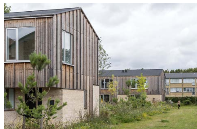
Tingbjerg huse, Tingbjerg, København. Boliger, rækkehuse. Vandkunsten.
