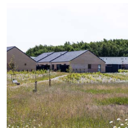
Astrid Lindgrensvej, Silkeborg. Boliger, rækkehuse. Sweco Architects.
