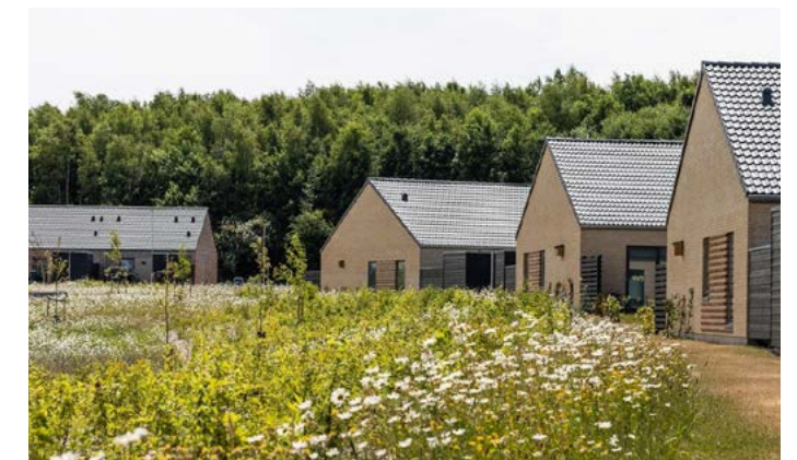
Astrid Lindgrensvej, Silkeborg. Boliger, rækkehuse. Sweco Architects.
