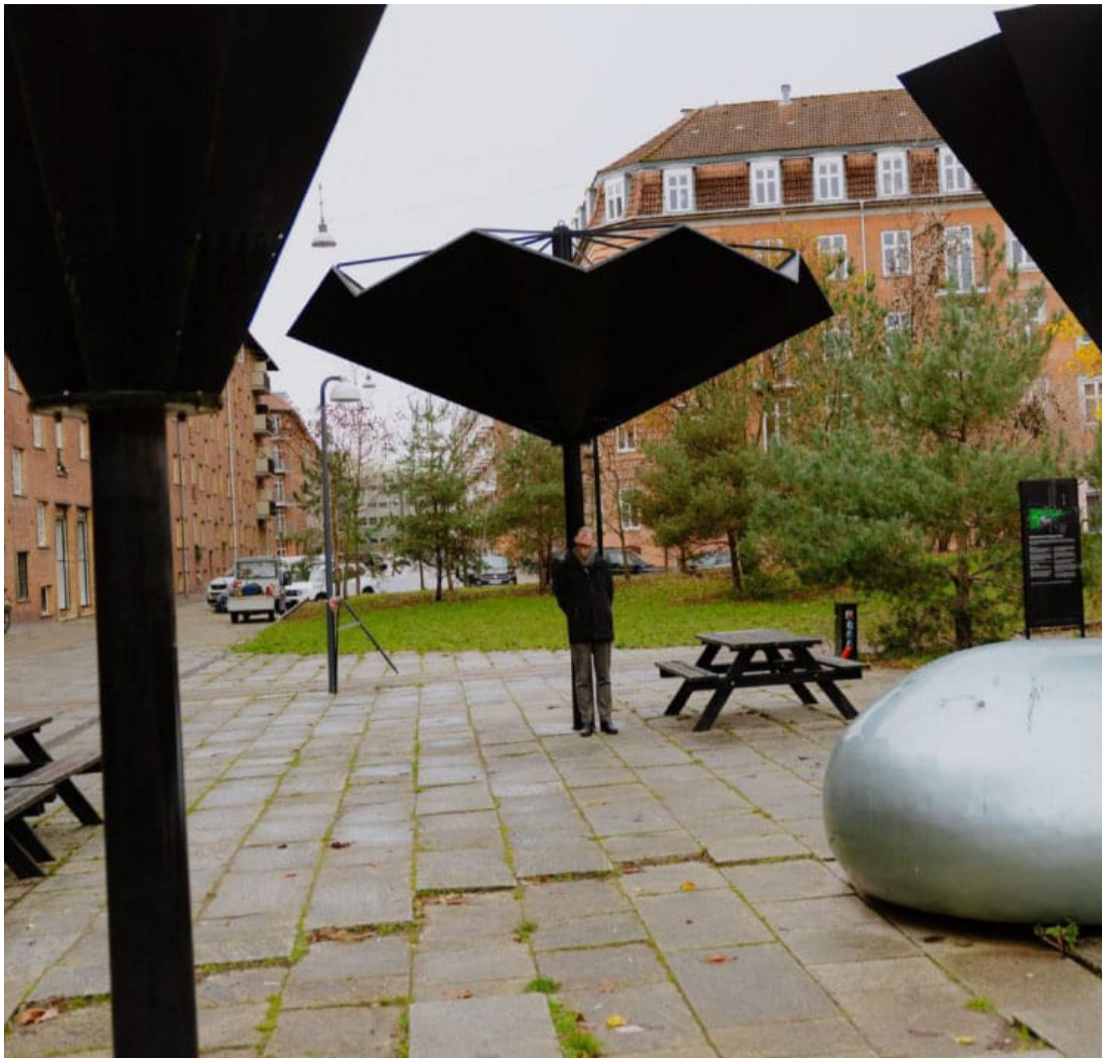
Pladsens regnparasoller leder både vand til nedsvivning og giver læ for regnen, mens man med pumper kan frigive en af de dråbeformede beholderes indhold af vand, så det føres ud i planterne. Fotos: Anders Holst
