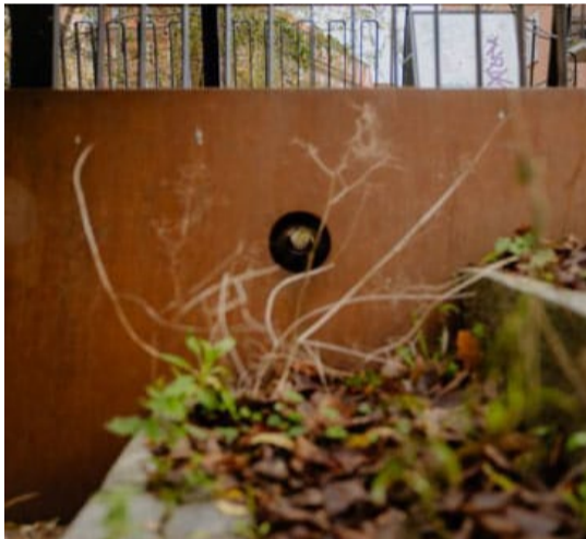
Renset regnvand føres rundt på pladsen til beplantningen, der er plantet efter "Vild Med Vilje"-princippet.
