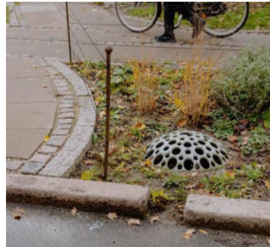
Pladsens vandsystem skåner kloaksystemet og rensningsanlægget for store mængder regn.
